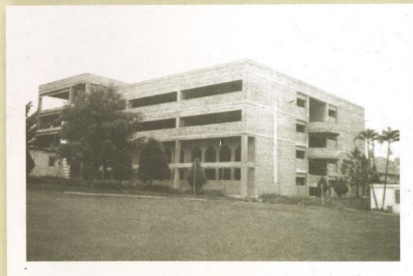
Nuevo edificio académico, llamado hoy Centro Académico Bolívar Rave.
