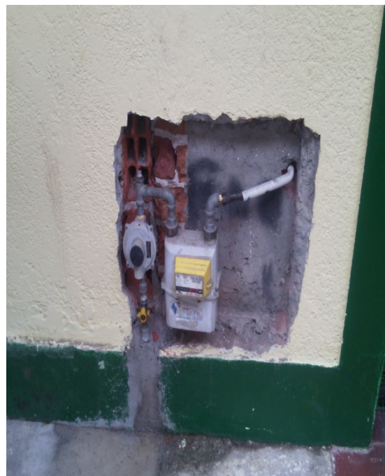
Ilustración 15. Falta de seguridad en contador
