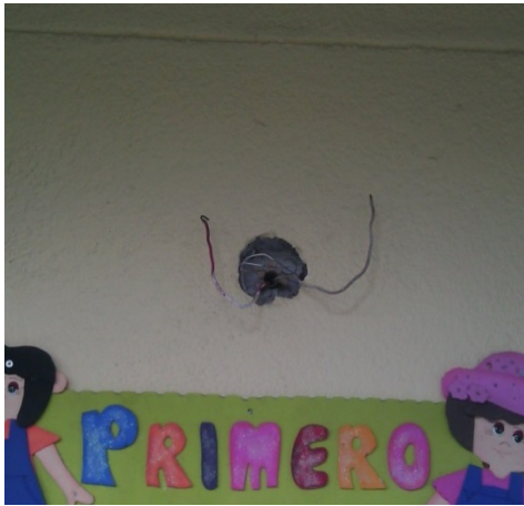
Ilustración 10: Cables sueltos.
