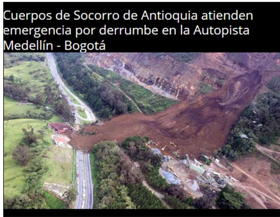
Elaborado por: Emergencia por derrumbe en autopista Medellín Bogotá (26)
