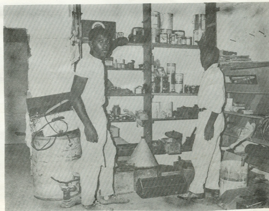
¿SE LE ROMPIÓ ALGO? EL SR. JUAN RODRIGUEZ LO ARREGLA MANTENIMIENTO
